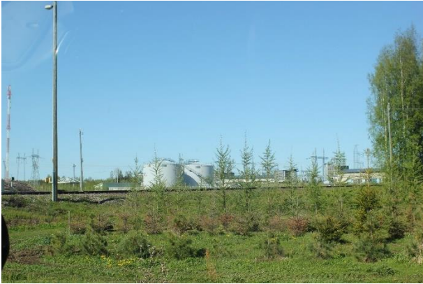
Kuva 22. Huutokosken sähkölaitos. Näkymä Rantatieltä, laitoksesta itään.
